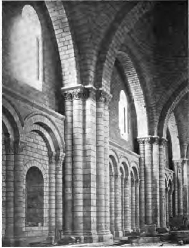
Fig. 131. — Nef de quatre travées couvertes en coupoles sur pendentifs à l'église abbatiale de Fontevraud.
